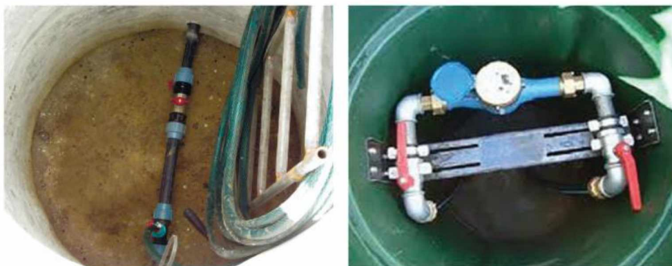
Рис. 11.7. Приклади влаштування вузлів вводу в колодязі
